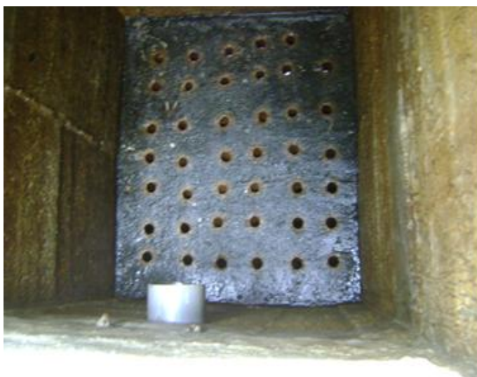
Foto 8. Pantalla deflectora a la salida del desarenador.
