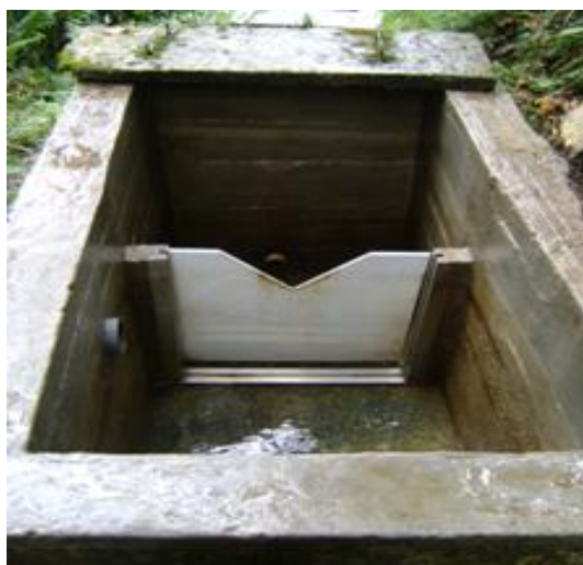
Foto 12. Estructura de regulación quebrada Montenegro.
