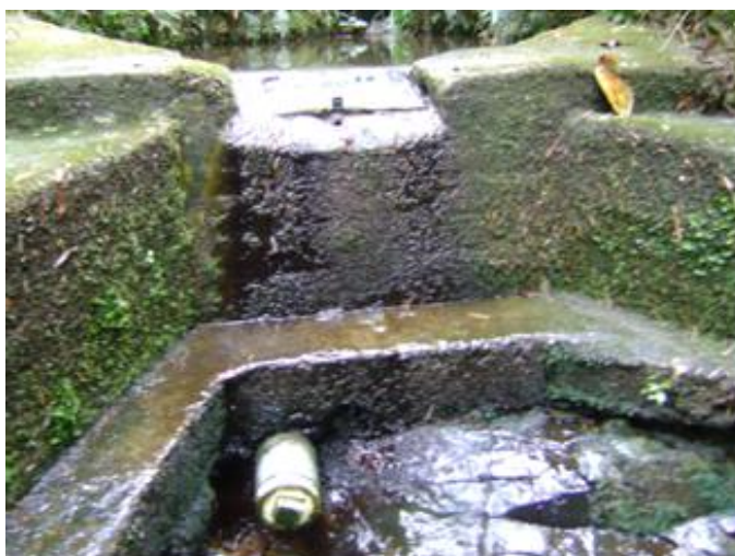
Foto 11. Bocatoma quebrada Montenegro
