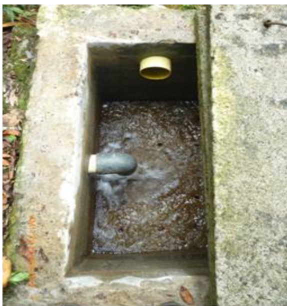
Foto 14. Zona de entrada desarenador quebrada Montenegro
