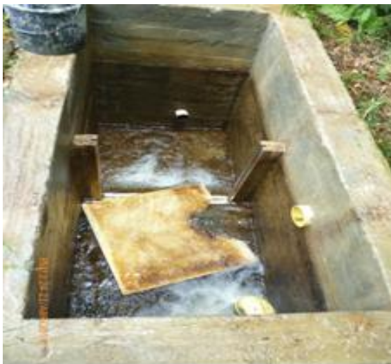
Foto 6. Estructura de regulación Quebrada San Francisco
