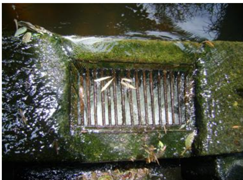
Foto 4. Rejilla de captación bocatoma San Francisco.
