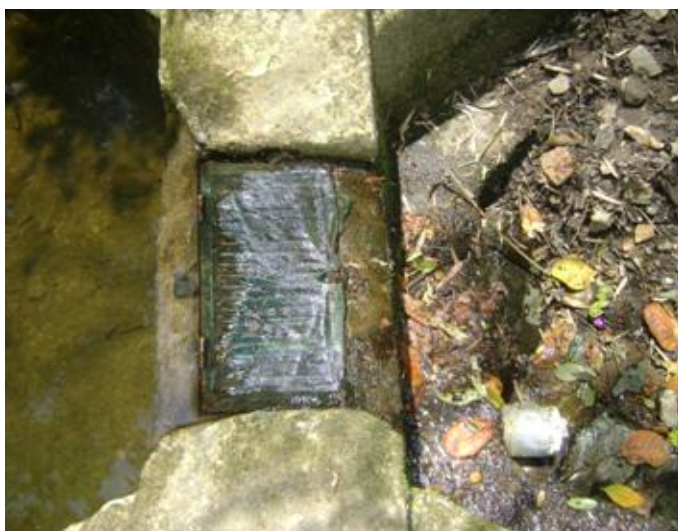
Foto 9. Rejilla de captación bocatoma Montenegro
