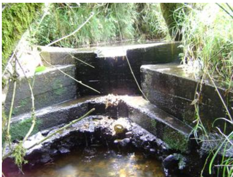
Foto 5. Socavación en la base de la bocatoma de la quebrada San Francisco.
