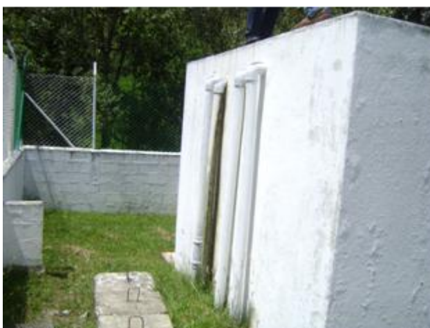
Foto 17. Entrada a los filtros del agua captada por las dos bocatomas.
