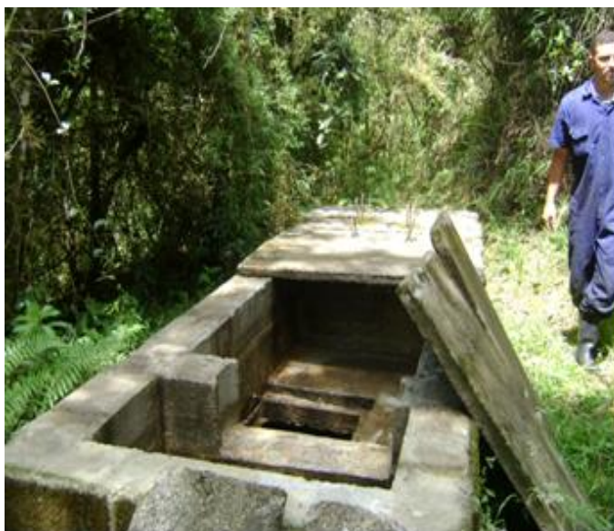
Foto 7. Desarenador del sistema de captación San Francisco.
